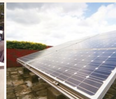
廣大帶領群聚研發的太陽能自主式汲水系統，可連續八小時抽取地下水。
